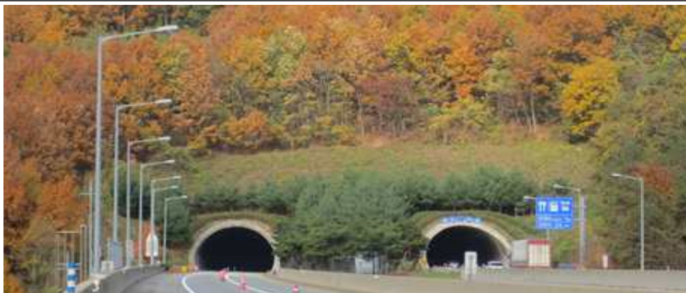
(시점부 절토사면 전경)
